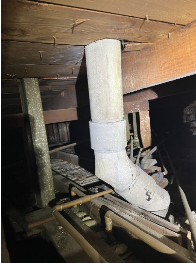
Possible asbestos
