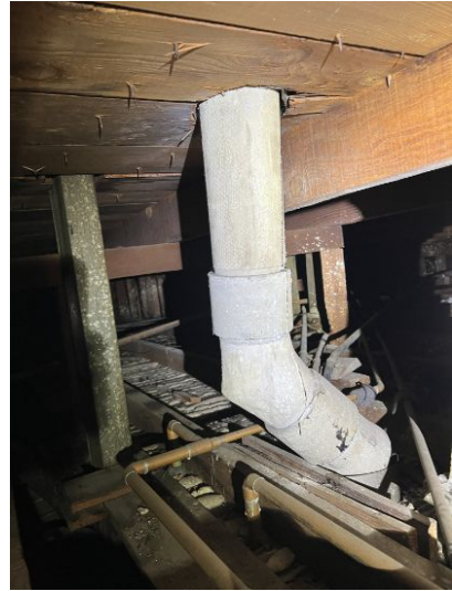
Possible asbestos
