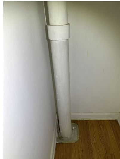
Possible asbestos
